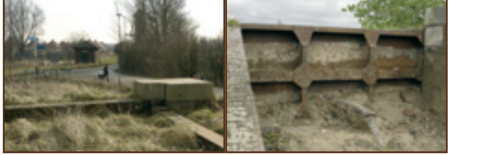
De coupure die na 1953 is dichtgegooid, is in 2006 uitgegraven en gerestaureerd.
